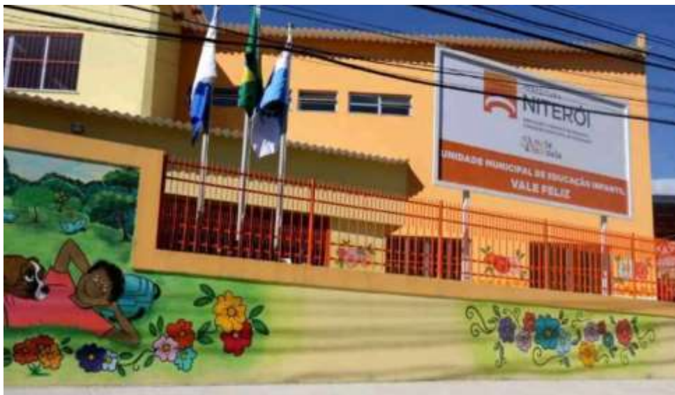
Figura 2 - Fachada da Unidade Municipal de Educação Infantil Vale Feliz
