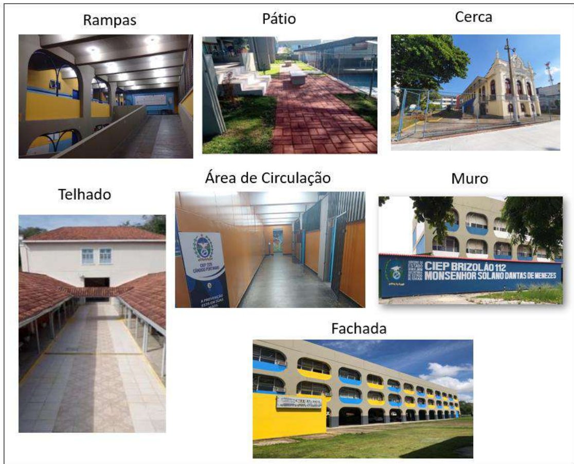
Figura 39 - Pátio, Muro, Cerca, Rampas, Escadas, Área de circulação, Telhado e Fachada
