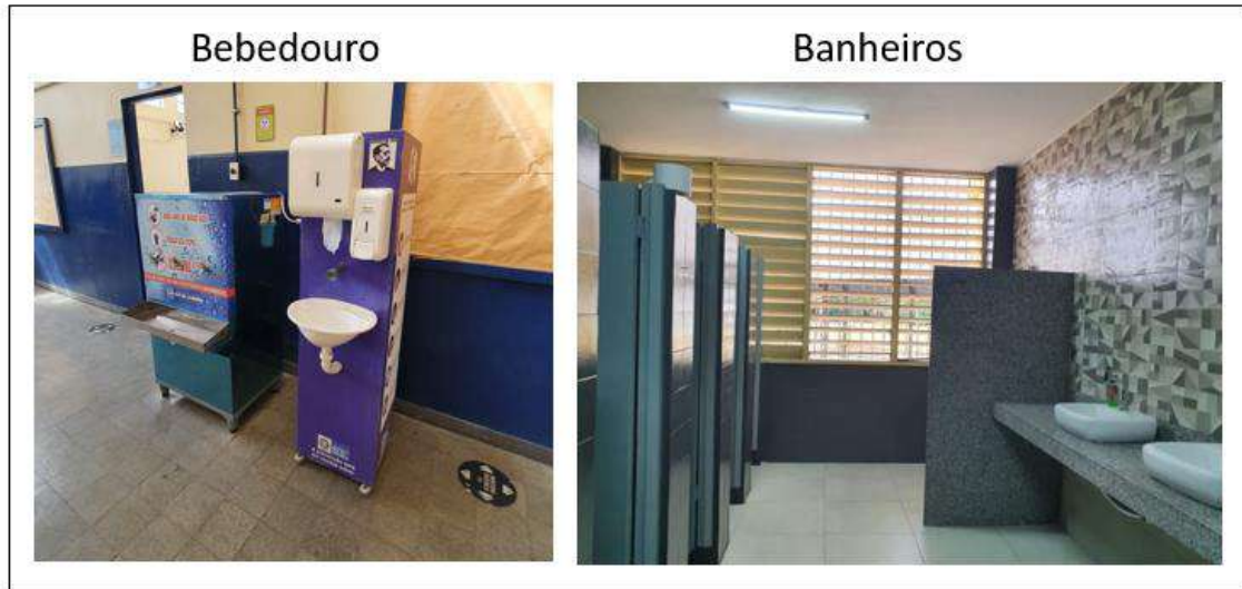
Figura 36 - Imagens de Bebedouro e Banheiro após intervenções na infraestrutura
