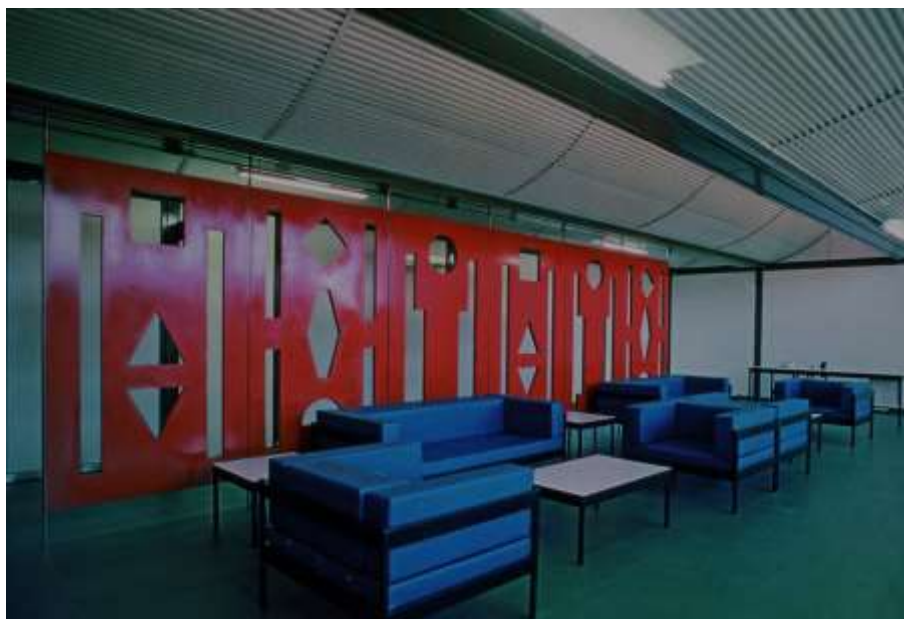
Figura 6 – Divisória em madeira laqueada, Tribunal de Contas do Estado do Espírito Santo, 1998.
