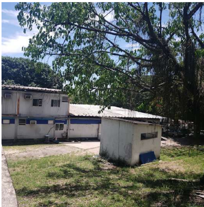
Figura 48 – UPA: vista interna do Parque
