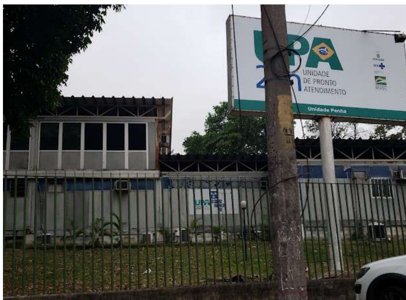
Figura 47 – Fachada frontal Parque Ary Barroso; UPA Penha
