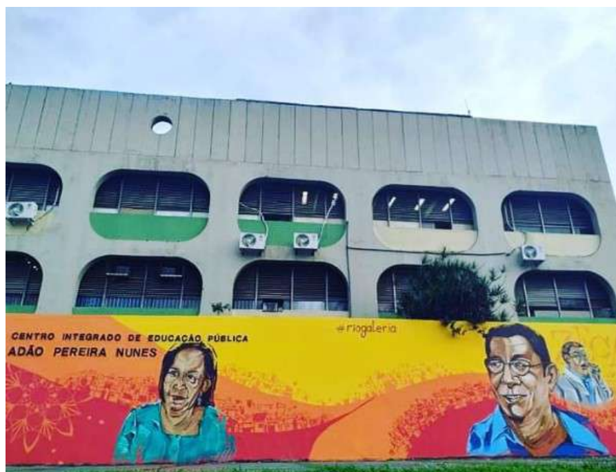
Figura 3 – Fachada do CIEP Dr. Adão Pereira Nunes
