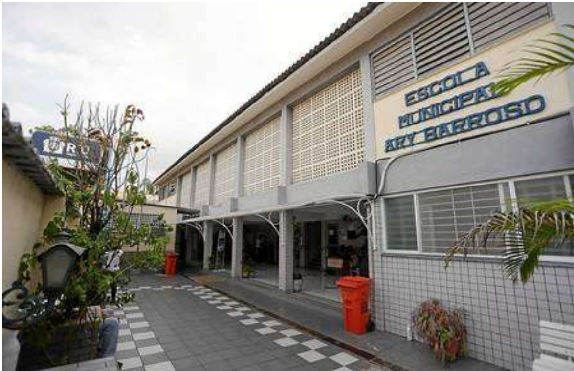
Figura 3 – Fachada da Escola Municipal Ary Barroso
