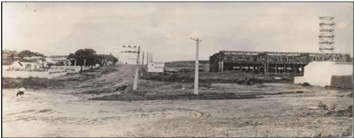
Figura 10 — Foto da etapa de construção da Escola Municipal Escultor Leão Velloso
