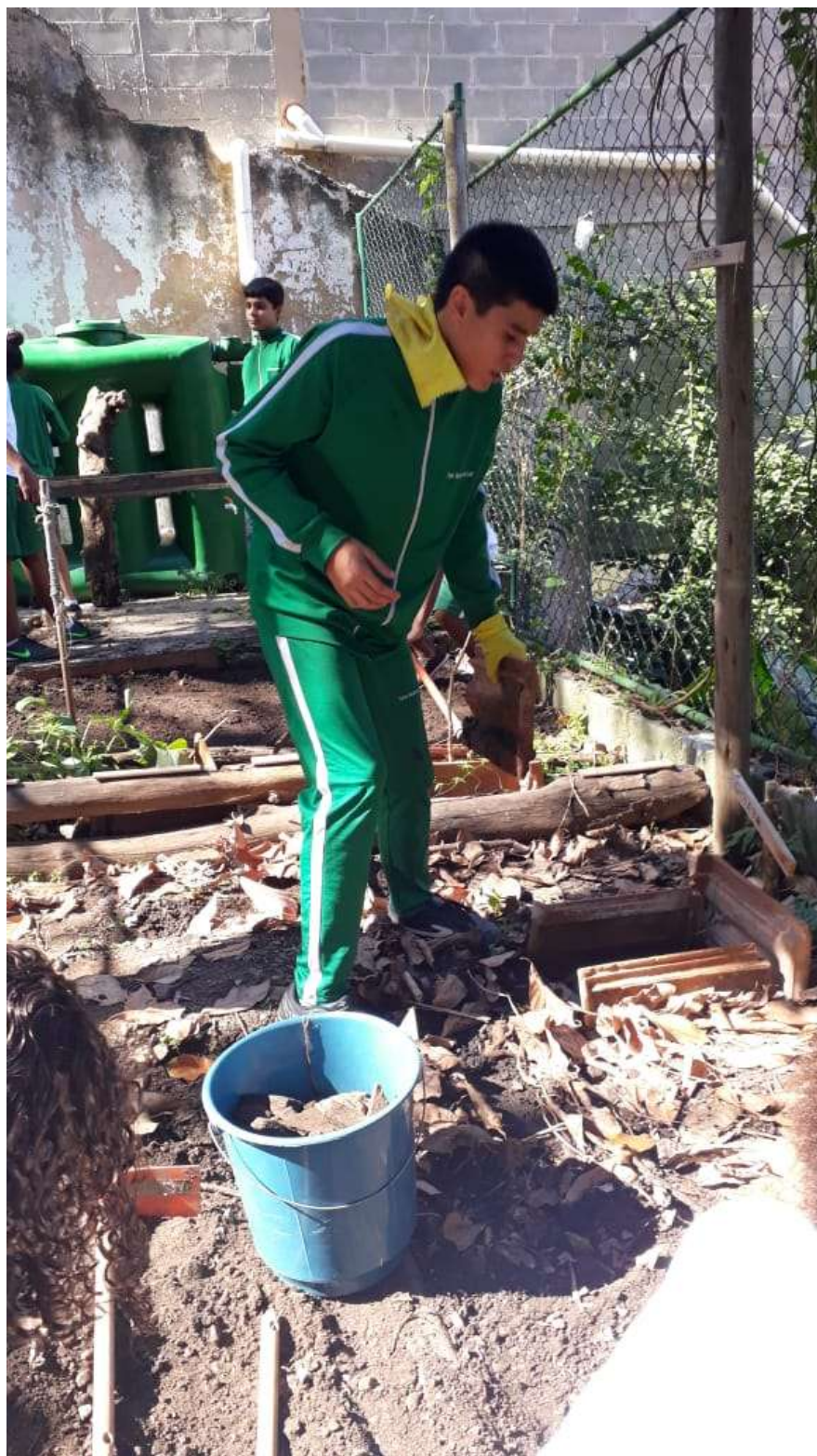
Figura 34 – Título: Limpeza de terreno para construção de horta. Fonte: turma do 8º ano – acervo da pesquisadora
